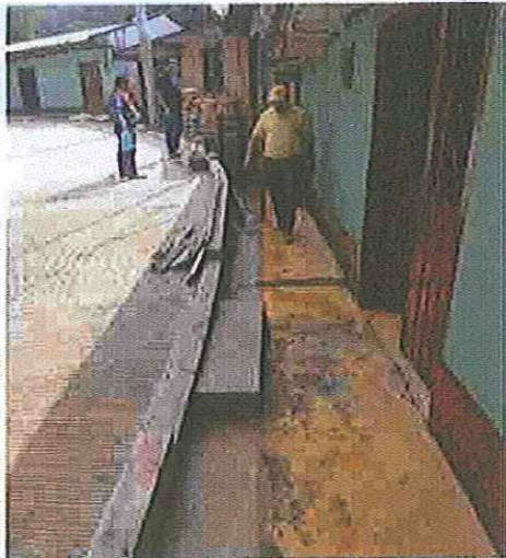
REPOSICION DE ANDENES AFECTADOS
