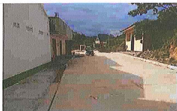
PLACA Y ANDENES TERMINADOS
