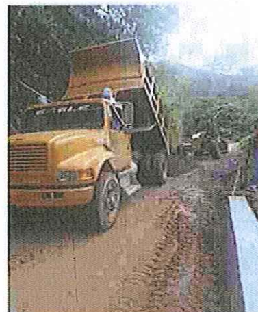
SUMINISTRO DE BASE GRANULAR
