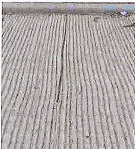
CORTE DE JUNTAS DE DILATACION
