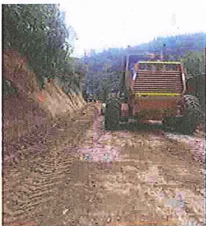
NIVELACION DE RASANTE
