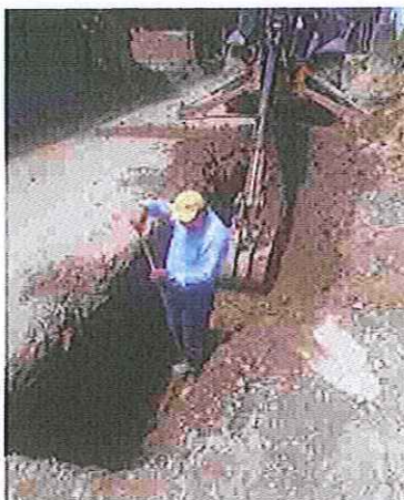
EXCAVACION DE FALLOS ENCONTRADOS
