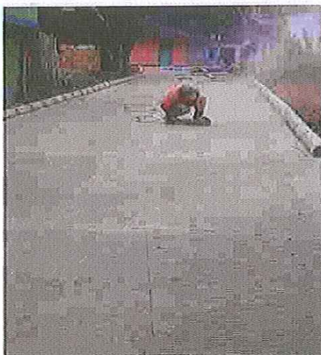
CORTE DE JUNTAS DE DILATACION
