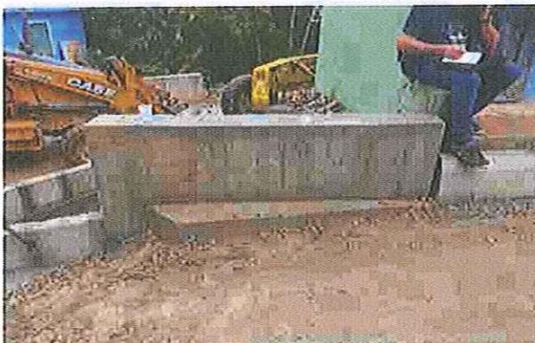
CONCRETO PARA ALCANTARILLAS
