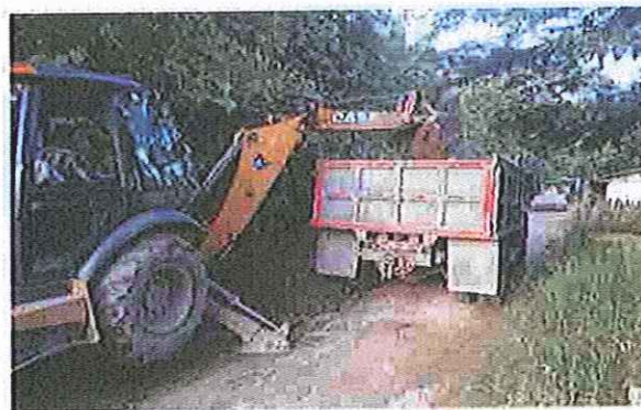
EXCAVACION Y TRANSPORTE DE MATERIAL
