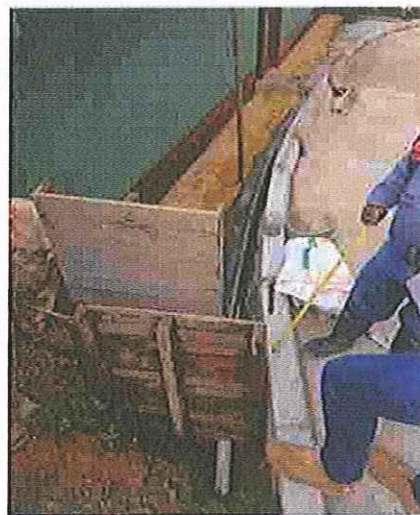
REPOSICION DE ANDENES
