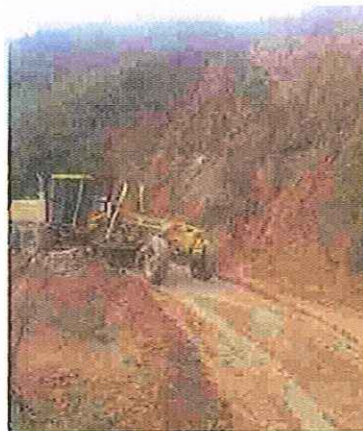
CAJEO Y CONFORAMACION
