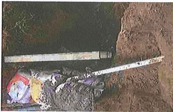
INSTALACION DE TUBERIA ACUEDUCTO
