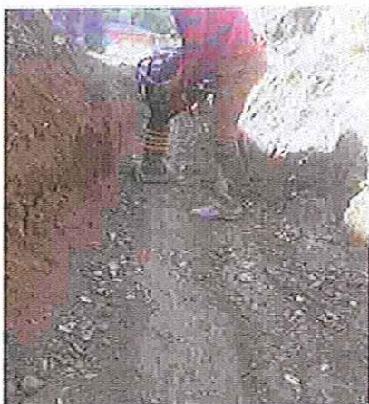
COMPACTACION DE RELLENOS
