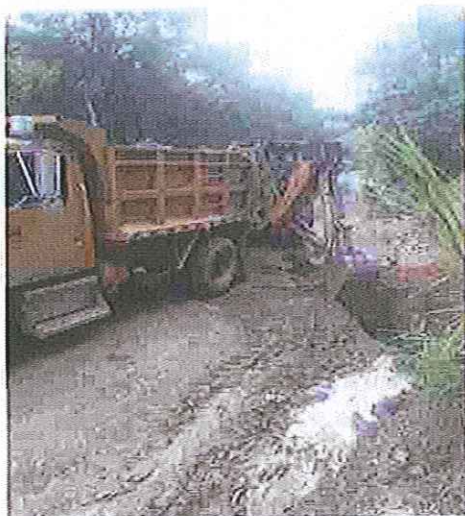
EXCAVACION Y TRANSPORTE
