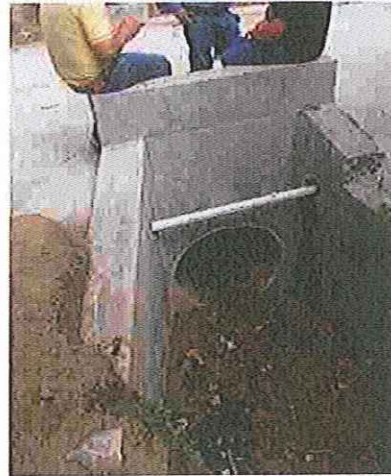
CONCRETO PARA ALCANTARILLAS
